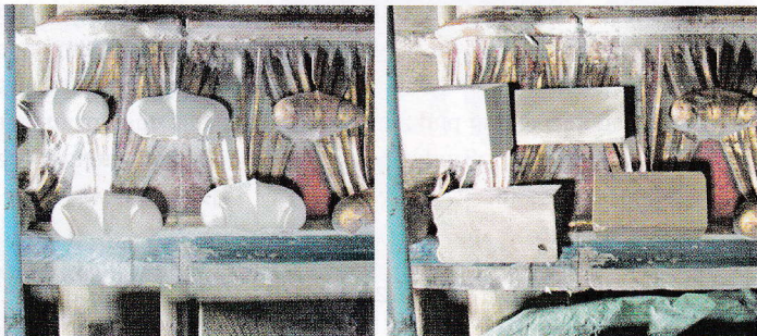
Das beschädigte bzw. fehlende Blattornament wurde mit einem Dübel versehen (l.), erhielt ein angekleb- tes Vierungssstück mit zusätzlicher Sicherung bis zum Abbinden (m.) und wurde gemäß den benachbarten Vorlagen nachgehauen (r.). Foto: Bungert & Wirtz
