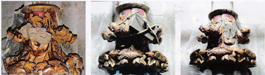
Das beschädigte bzw. fehlende Blattornament wurde mit einem Dübel versehen (l.), erhielt ein angekleb- tes Vierungssstück mit zusätzlicher Sicherung bis zum Abbinden (m.) und wurde gemäß den benachbarten Vorlagen nachgehauen (r.). Foto: Bungert & Wirtz
